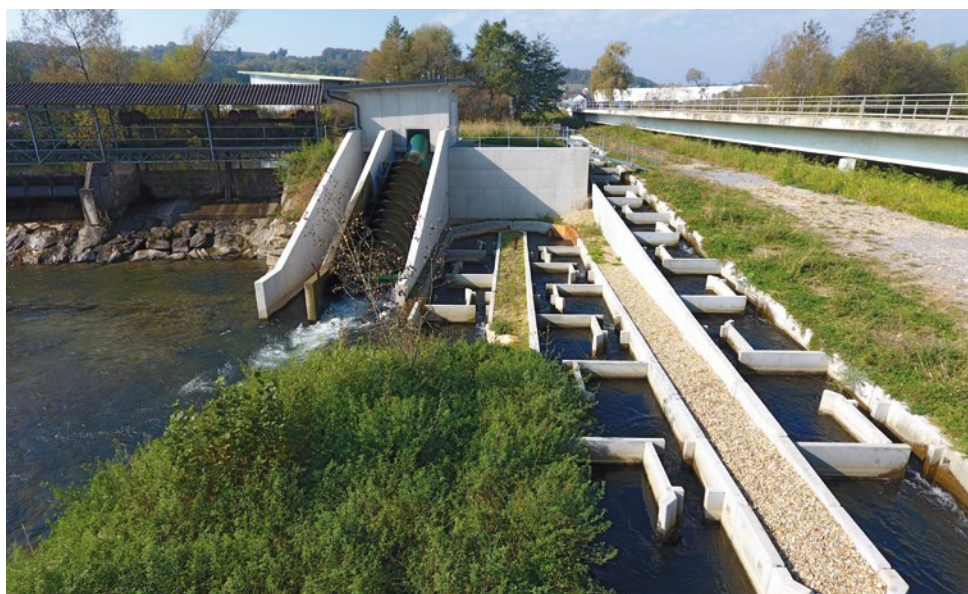
Fischaufstieg und Restwasserschnecke zur Versorgung von ca. 70 Haushalten
