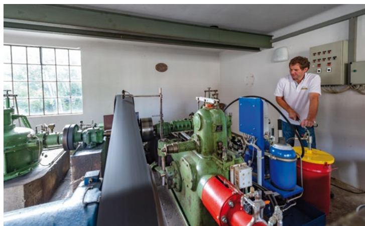
Schmierarbeiten bei der Turbine Baujahr 1958
