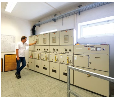
20 kV Mittelspannungs-Schaltanlage
